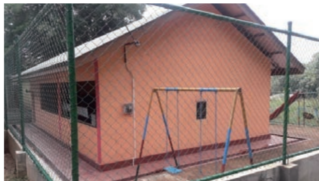
池上様の支援により建設された幼稚園園舎
