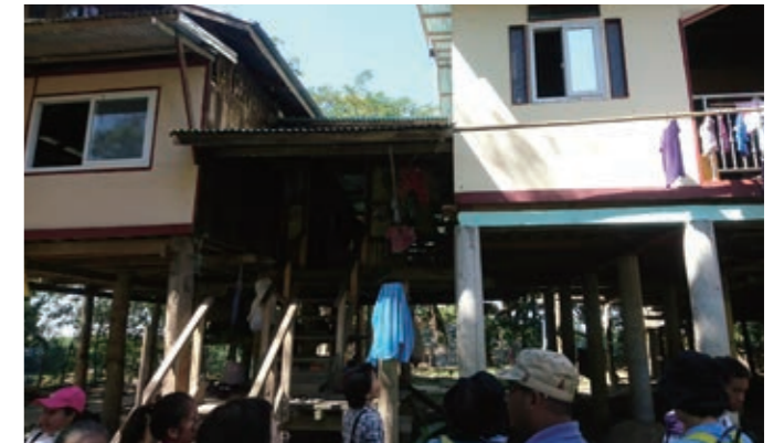
木製の柱の家(左)とコンクリート製の柱の家(右)。雨期には右側の家の床(明るい緑色の部分)まで水がきます
