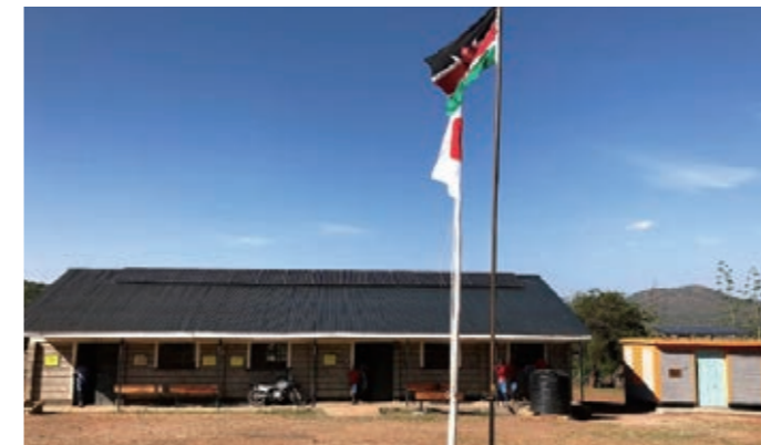
小学校と診療所に太陽光発電・蓄電システム（右の黄色い建物）を設置（写真は小学校）
