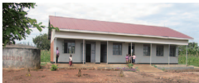
ADPの支援で建設された新しい校舎
