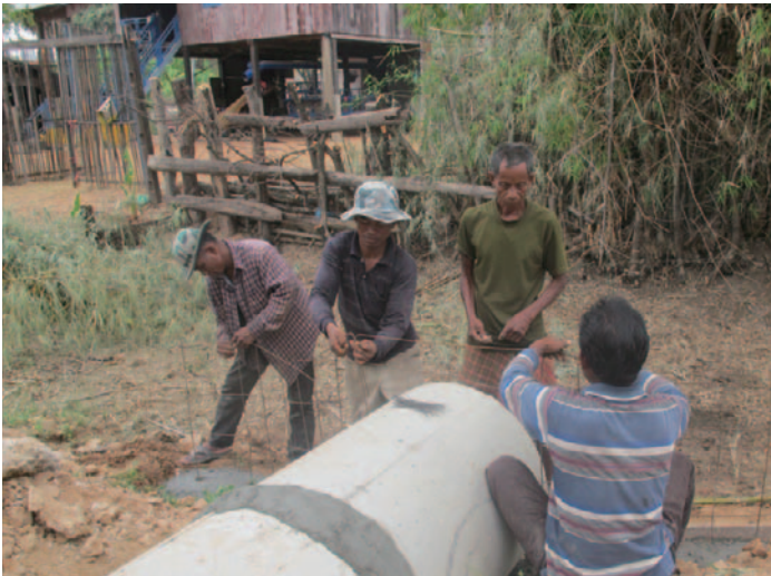
給水用の配管工事に参加する地域住民
