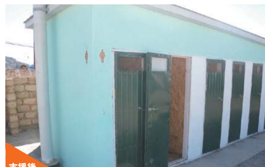
支援後 新たに建設されたトイレ
