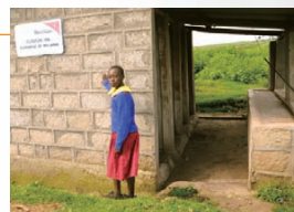
小学校に建設されたトイレ (2011年)
