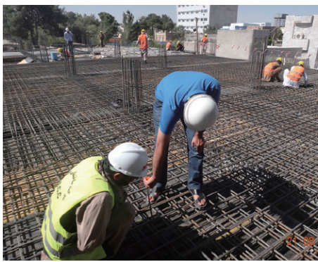
施工管理技士(写真右)による鋼材の確認作業。建設資材の質の管理も徹底されています
