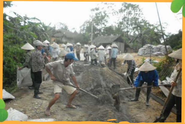
地域住民が協力し、道路の舗装を行いました
