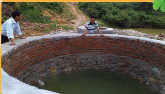
住民が自ら計画し、建設された井戸
