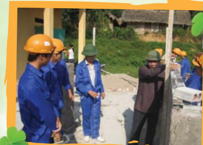
建設技術についての職業訓練の様子
