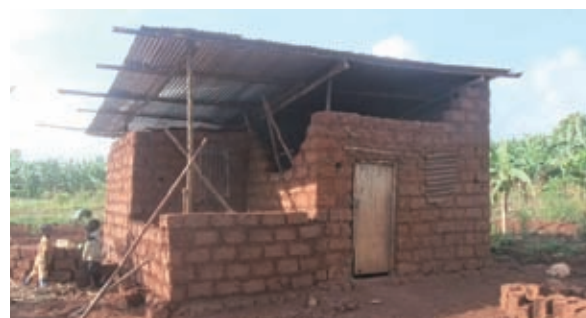
トタン板で屋根を建築中の住宅
