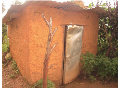
各世帯に設置されたトイレ
