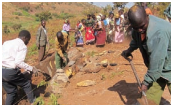
ワールド・ビジョンからの支援によって建設中の灌がい用水路
