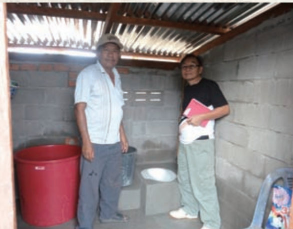
支援により完成したトイレには丈夫な壁や屋根がつけられています
