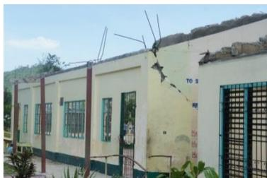
台風により屋根が破損した小学校の校舎
