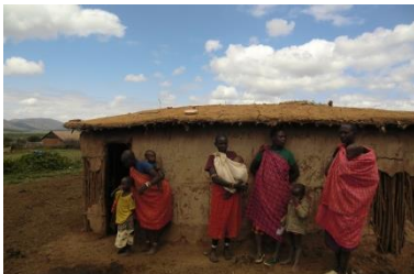
支援地域の住居の様子。壁は木の枝の隙間を牛糞で固めて作られています。遊牧のために移動する場合は、新しい土地でまた家を建てます
