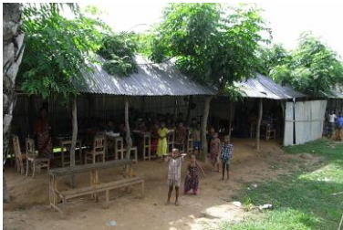
支援地域の小学校 一部壁がなく床は土です
